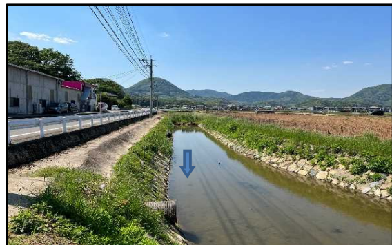
浚渫が完了した河川
