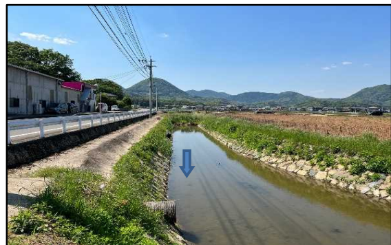
浚渫が完了した河川
