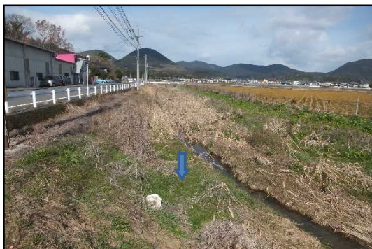
土砂が堆積した河川
