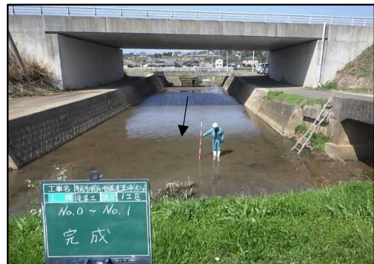
浚渫が完了した河川
